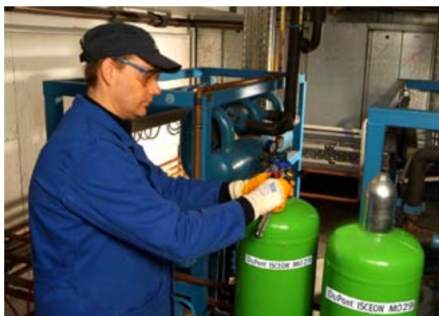
Fot. 1. Napełnianie instalacji chłodniczej hipermarketu czynnikiem Isceon ® MO29
